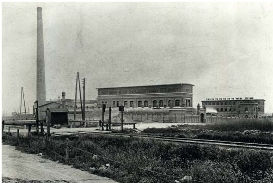
Ill. 4 Anonym/anonyme, Kabelfabrik Aktien Gesellschaft vormals Otto Bondy/câblerie SA jadis Otto Bondy , Wien-Meidling 1905, Bezirksmuseum Meidling, Wien/Vienne
